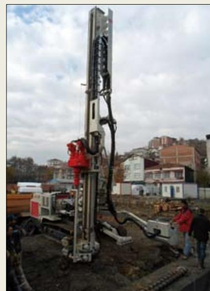
Grazie a circuiti idraulici di concezione avanzata, la perforatrice Comacchio MC 15 prevede un ampio assortimento di teste e martelli che si prestano alle più svariate tipologie di perforazione, sia a rotazione che a rotopercolazione. Tutte le macchine possono essere equipaggiate con comandi idraulici proporzionali o con radiocomando in grado di controllare tutte le funzioni della macchina, compreso il caricamento aste
