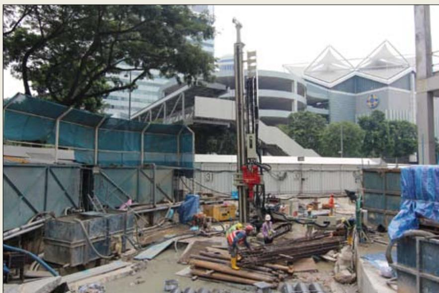
La MC 15 appartiene a una gamma di perforatrici cingolate ideali per opere specializzate di ingegneria civile (micropali, ancoraggi, jet-grouting e consolidamenti in genere) e che consentono di raggiungere una grande varietà di posizionamenti e inclinazioni del mast, nonché di operare in spazi ridotti, coprendo allo stesso tempo un'ampia area di lavoro e mantenendo elevate prestazioni
