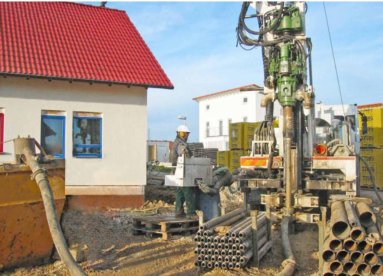
La linea GEO GT comprende anche una perforatrice installata su camion (serie MC-T GT), che garantisce la massima rapidità e efficacia di mobilitazione e messa in opera. La macchina si adatta perfettamente alla realizzazione di progetti che utilizzano tecniche di perforazione con rivestimento.
