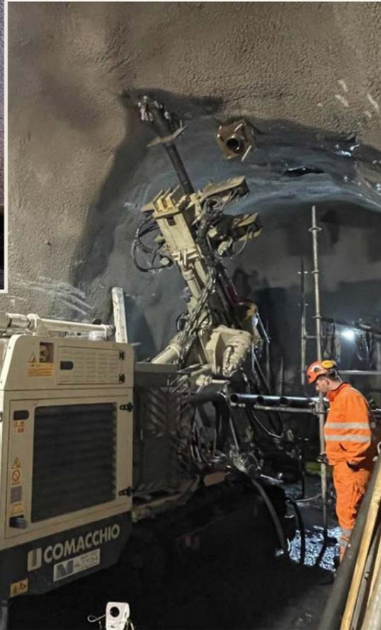
si realizzano le perforazioni di drenaggio all'interno del cunicolo, la corretta e attesa diminuzione di pressione dell'acqua. "Ad oggi abbiamo registrato un quantitativo massimo di acque derivante da un singolo foro di drenaggio nell'ordine di 200 l/min - ci aggiorna Matteo Muttoni - Nella zona successiva di intervento sono previsti fino a 1.000 l/min, motivo per il quale la perforazione verrà eseguita installando un sistema di 'preventer'".
