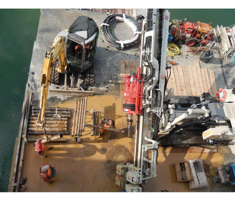
raggi, jet grouting e consolidamenti in genere. Il tratto distintivo della MC 15 è la varietà di posizionamenti e inclinazioni raggiungibili grazie al sistema brevettato di articolazione del mast, che ne consente l'impiego anche in spazi ridotti. Dotata di circuiti idraulici modulari di concezione avanzata, la MC 15 può montare una vasta scelta di teste di rotazione, martelli idraulici, sistemi
