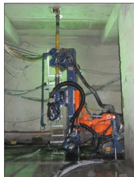
For the drilling operations contractor Pilotest Terratest chose a Comacchio drill rig MC 3 D with a separate power pack/Per le operazioni di perforazione l'impresa Pilotest Terratest ha scelto una perforatrice Comacchio MC 3 D con centrale idraulica separata
