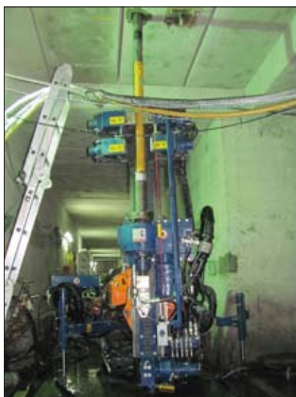
For the drilling operations contractor Pilotest Terratest chose a Comacchio drill rig MC 3 D with a separate power pack/Per le operazioni di perforazione l'impresa Pilotest Terratest ha scelto una perforatrice Comacchio MC 3 D con centrale idraulica separata
