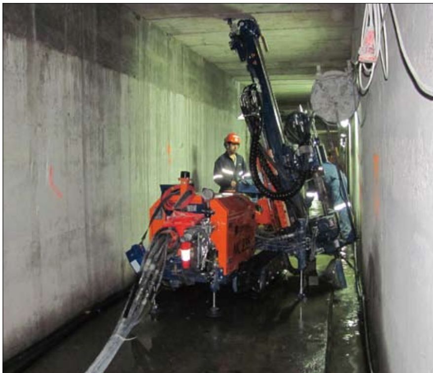
The mast has 1,200 mm feed stroke, offering 2500 daN feed/retract force, this allows for operation in low overhead conditions//Il mast ha 1200 mm di corsa, a fronte di 2,500 daN di tiro-spinta, il che consente di operare in condizioni di altezza ridotta
